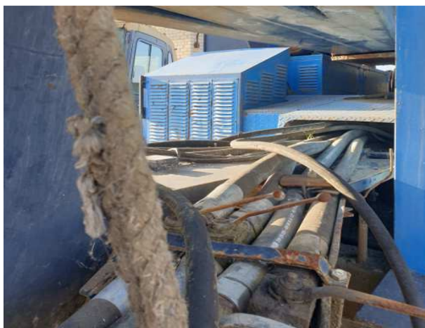
Фото 8. Бурильная установка (копёр) JUNTTAN PM-30 (НК-10), гос. рег. знак 77АС8254, 1994 года выпуска
